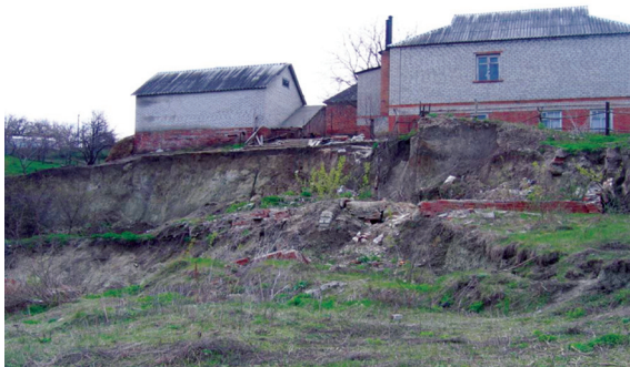
Рис. 5. Зсув на схилі стримкістю 5° на підтоплених лесових ґрунтах (м. Куп'янськ, Харківської обл.)
